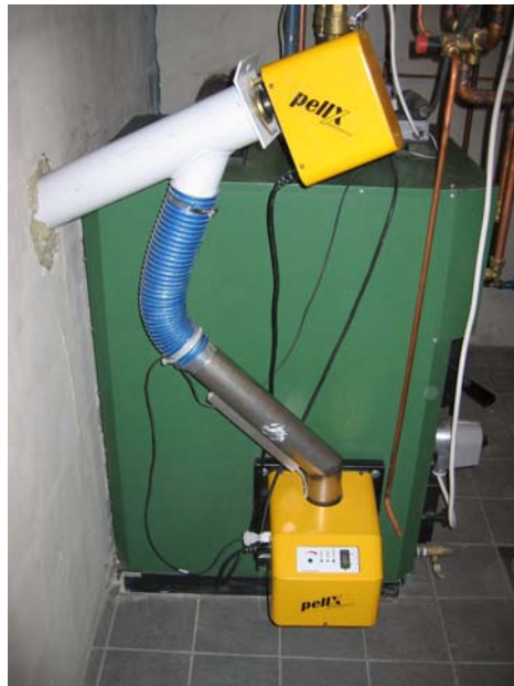
Kuva 4.11. Ruotsalainen PellX-pellettipoltin asennettuna lämmityskattilaan.
