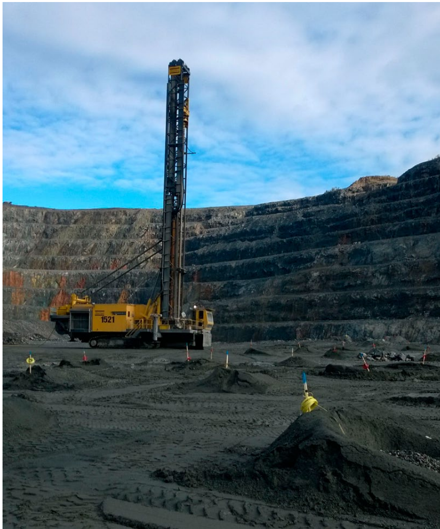
Kuva 21. Räjätyskenttää avolouhoksessa. Kuva: © T. Kauppila, GTK. Fig. 21. Blast holes in an open pit. Photo: © T. Kauppila, GTK.
