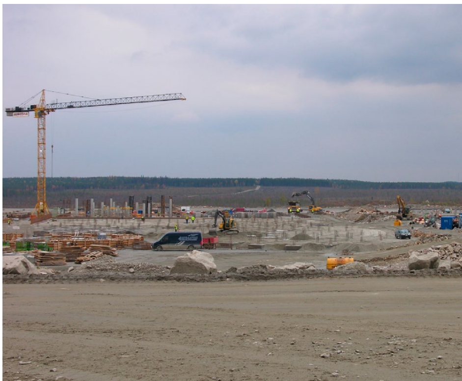
Kuva 4. Kaivosalueen rakentaminen muuttaa alueen maisemaa. Kuva: © P. Kauppila, GTK. Fig. 4. Construction of a mine changes the landscape of the site. Photo © P. Kauppila, GTK.
